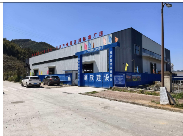
集装箱板生产厂区现状
