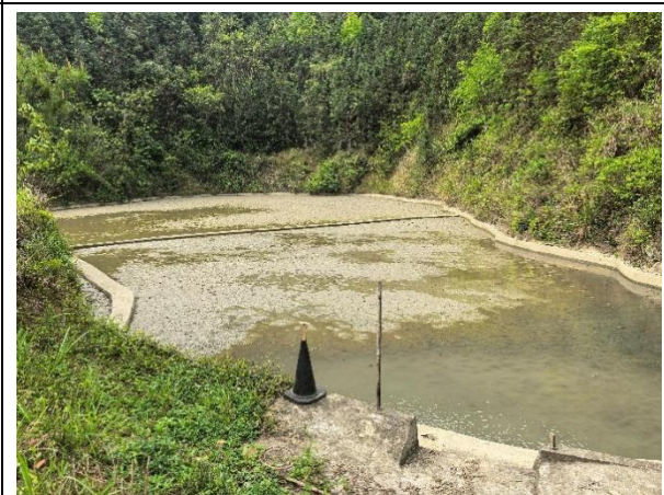
项目废水暂存池现状
