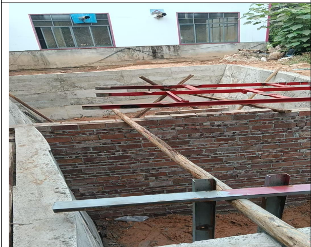
厂房外西面冷却水池在建 （2025.10.22 拍摄）
