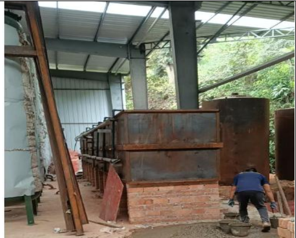
冷却槽已安装（2025.10.22 拍摄）
