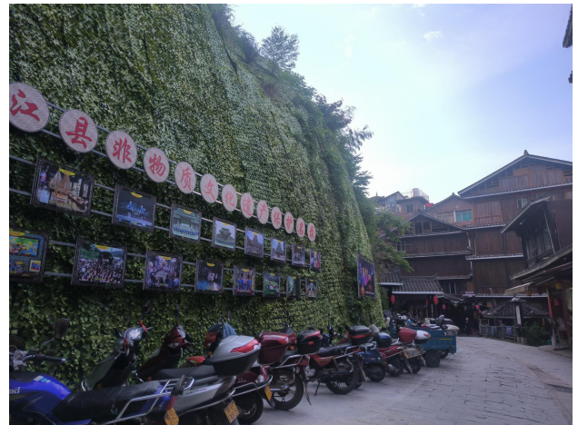
照片 3-34 程阳不稳定斜坡一号现状图
