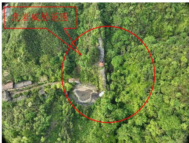
照片 3-15 三江县丹洲镇石门冲景区危岩现状全景图
