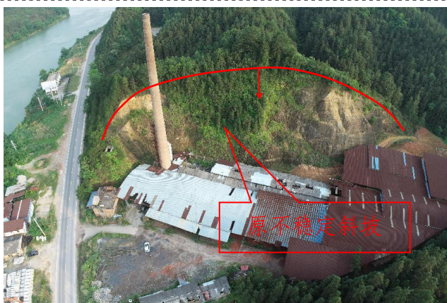
照片 3-17 大兰坪页岩砖厂不稳定斜坡现状全景图
