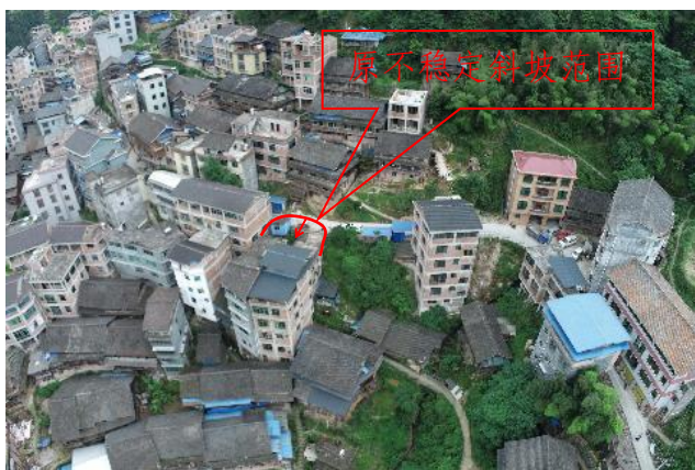
照片 3-63 独峒镇唐朝村唐朝屯不稳定斜坡现状全景图
