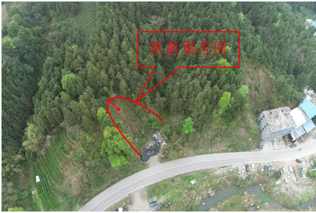
照片 3-65 下林江屯 4 号崩塌现状全景图
