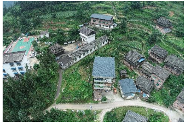
照片 3-56 福田屯吴柳青家屋侧崩塌现状全景图
