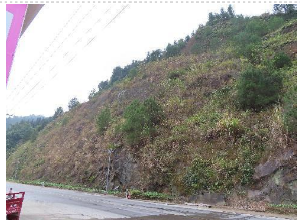
照片 3-38 三江县 209 公路崩塌现状图
