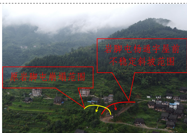
照片 3-47 岩脚屯杨通宇屋前不稳定斜坡全景图
