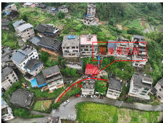
照片 3-57 三江县程村乡大树村佳林屯侯水德户崩塌现状全景图
