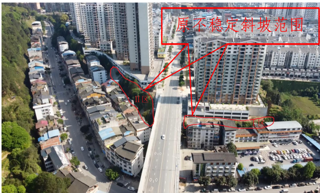
照片 3-27 原苏城桥头不稳定斜坡全景图
