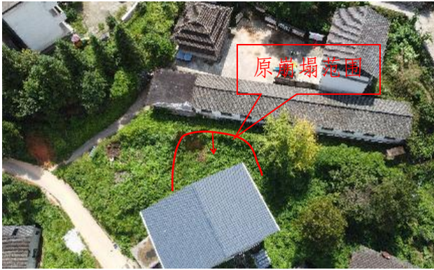
照片 3-55 原福田屯吴柳青家屋侧崩塌全景图
