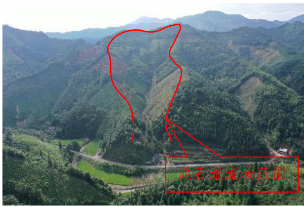
照片 3-67 江源屯泥石流现状全景图
