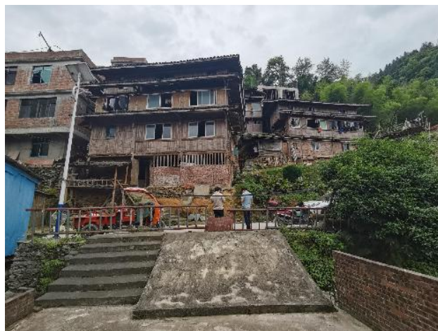
照片 3-64 独峒镇唐朝村唐朝屯不稳定斜坡现状图
