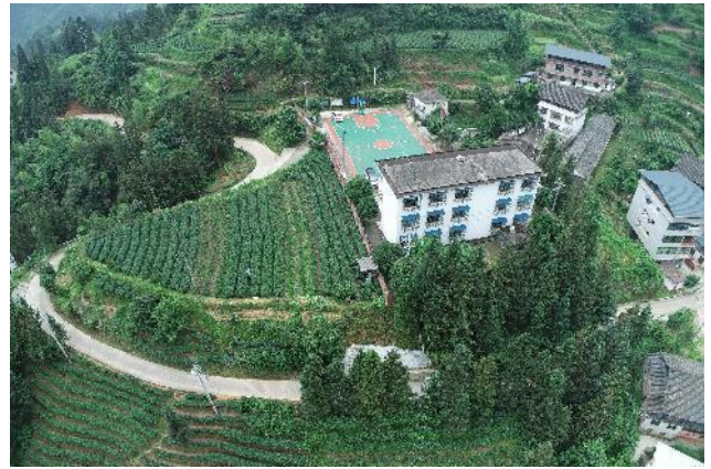
照片 3-54 福田屯崩塌--福田小学现状全景图
