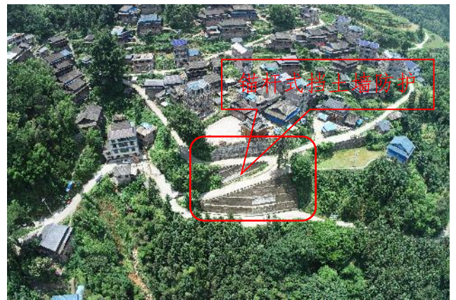
照片 3-24 白文屯崩塌现状全景图
