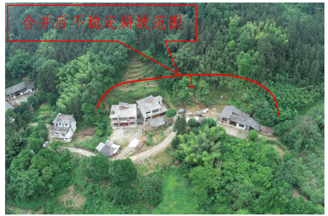
照片 3-52 合并后立新屯房文云屋后不稳定斜坡现状全景图
