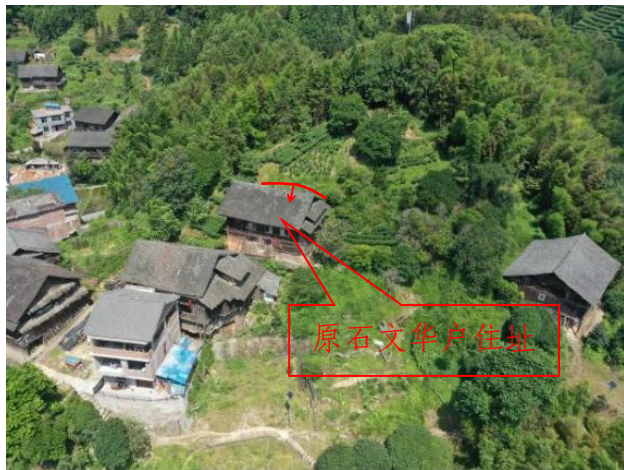
照片 3-5 原三江县斗江乡凤凰村中广屯（石文华）屋后崩塌全景图
