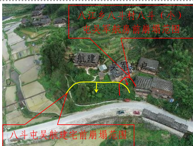
照片 3-49 八江乡八斗村八斗（小）屯吴军航房前崩塌现状图
