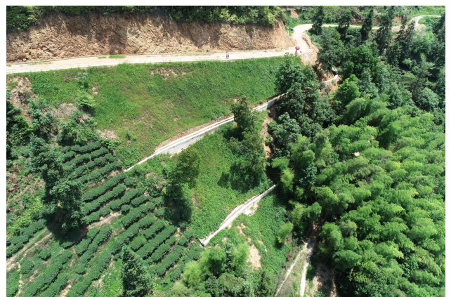
照片 3-30 井板屯滑坡现状图
