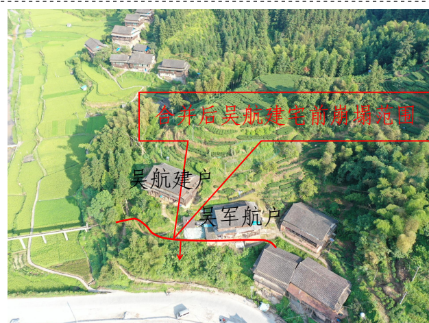
照片 3-50 合并后八斗屯吴航建宅前崩塌现状全景图
