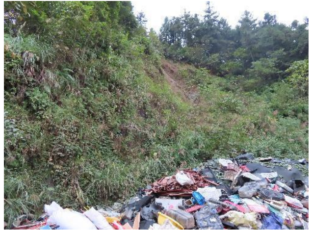
照片 3-66 下林江屯 4 号崩塌现状图
