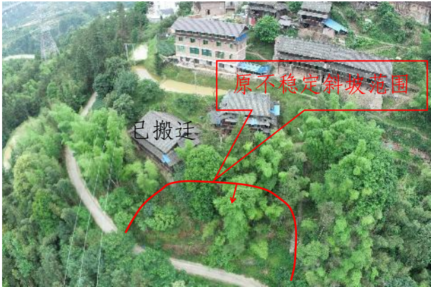
照片 3-61 独峒镇知了村归滚屯（杨通芳屋前）不稳定斜坡现状全景图
