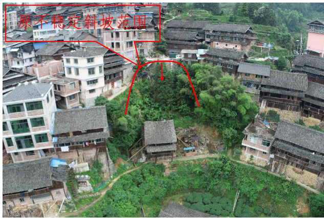
照片 3-59 独峒镇知了村知了屯（杨涓屋后）不稳定斜坡现状全景图
