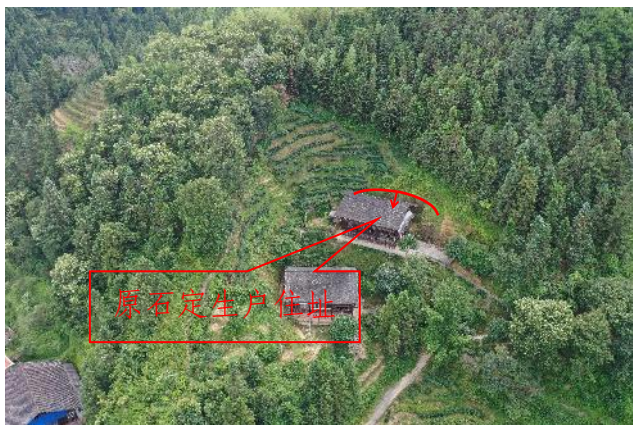
照片 3-3 原三江县斗江镇凤凰村中广屯（石定生）崩塌全景图
