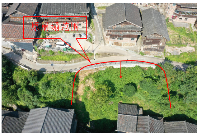
照片 3-31 原高友屯上寨崩塌全景图
