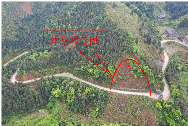
照片 3-43 原吉昌屯崩塌 3 全景图
