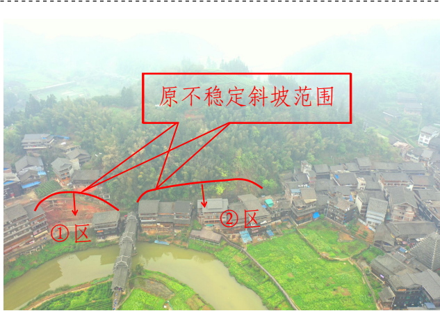
照片 3-33 原程阳不稳定斜坡一号全景图
