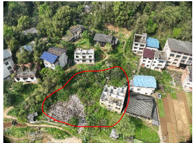
照片 3-8 古宜镇大洲村委洲上屯滑坡全景现状图
