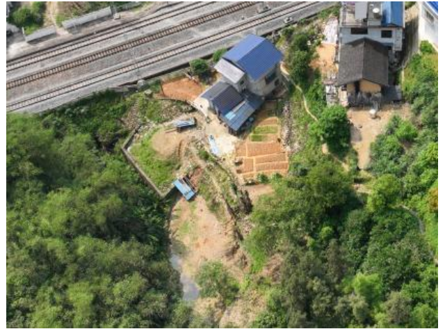
照片 3-2 丹洲镇六孟村各亮屯（梁家耀户） 不稳定斜坡现状现状图
