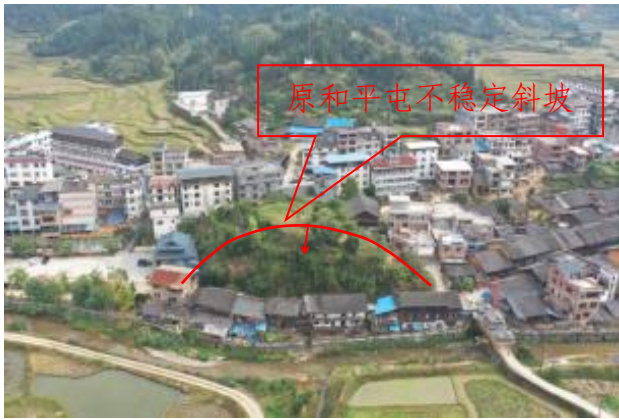
照片 3-21 原和平屯不稳定斜坡现状全景图
