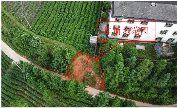
照片 3-53 原福田屯崩塌--福田小学全景图
