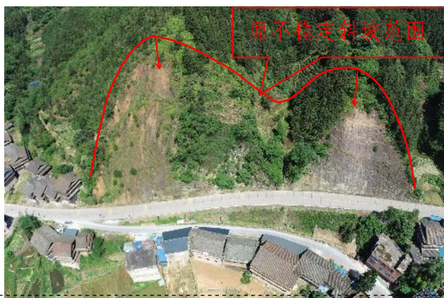
照片 3-39 金鸡屯东侧 S506 公路不稳定斜坡现状全景图
