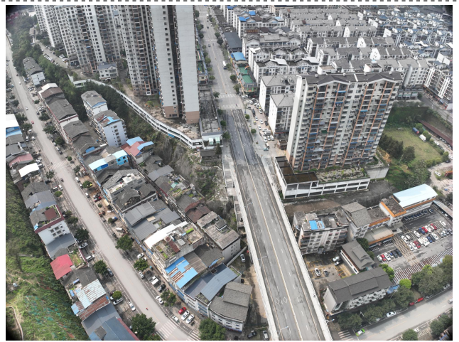
照片 3-28 苏城桥头不稳定斜坡现状全景图
