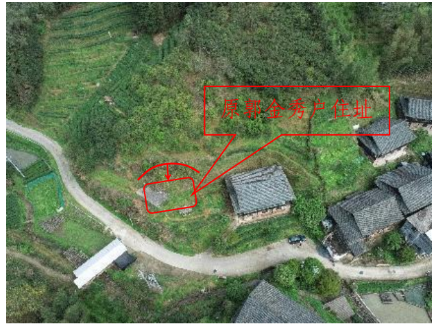
照片 3-10 古宜镇古皂村三冲屯（郭金秀） 崩塌全景现状图
