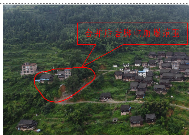
照片 3-48 合并后岩脚屯崩塌现状全景图
