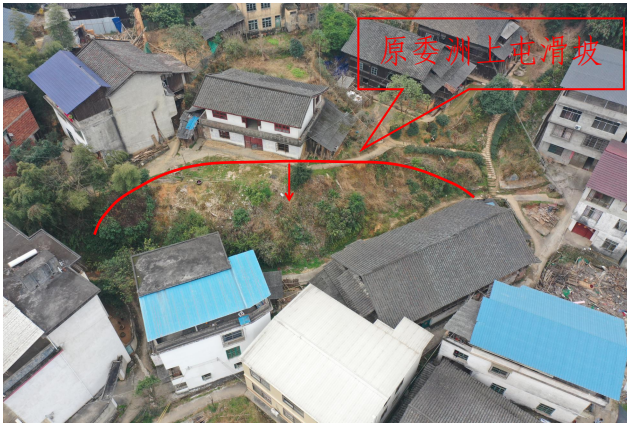
照片 3-7 原古宜镇大洲村委洲上屯滑坡全景图
