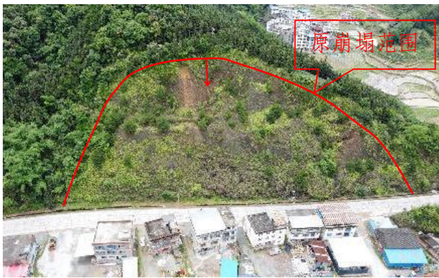
照片 3-37 三江县 209 公路崩塌现状全景图
