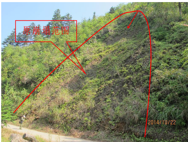
照片 3-35 三江县高基乡冲干村东山屯覃文才屋后（公路边）崩塌现状图 1
