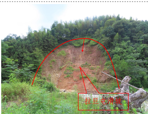
照片 3-19 拉旦屯滑坡现状全景图
