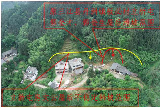
照片 3-51 原三江县丹洲镇板必村立折屯郭金才、郭金生屋后滑坡全景图
