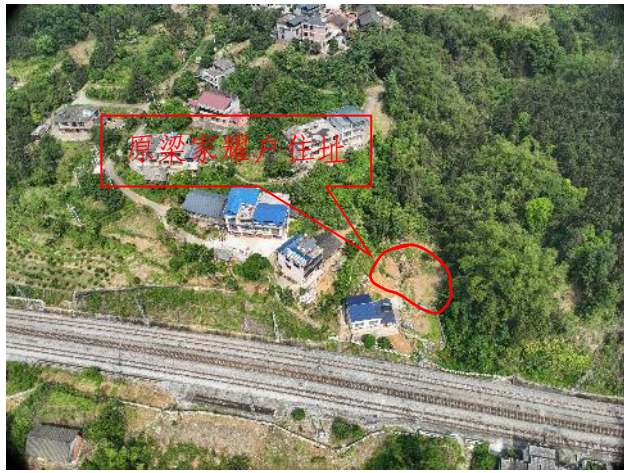
照片 3-1 丹洲镇六孟村各亮屯（梁家耀户） 不稳定斜坡现状全景图
