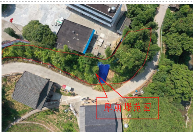
照片 3-25 原古这屯小学崩塌全景图
