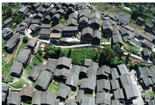
照片 3-32 高友屯上寨崩塌现状全景图
